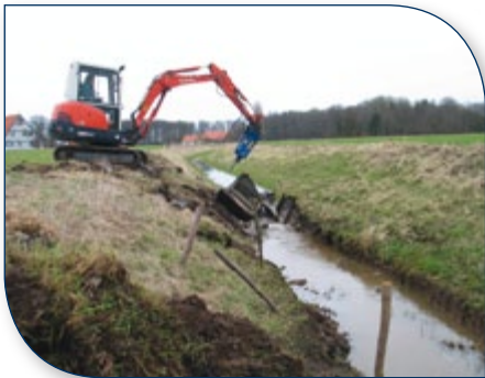
Die ersten Rückbaumaßnahmen am Gestringer Bach sind bereits erfolgreich abgeschlossen worden.
