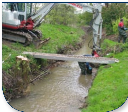
An der Großen Aue wurden die Rasengittersteine aus den Böschungen genommen, um die Bachsohle zu verbreitern und die Ufer abzufachen.
