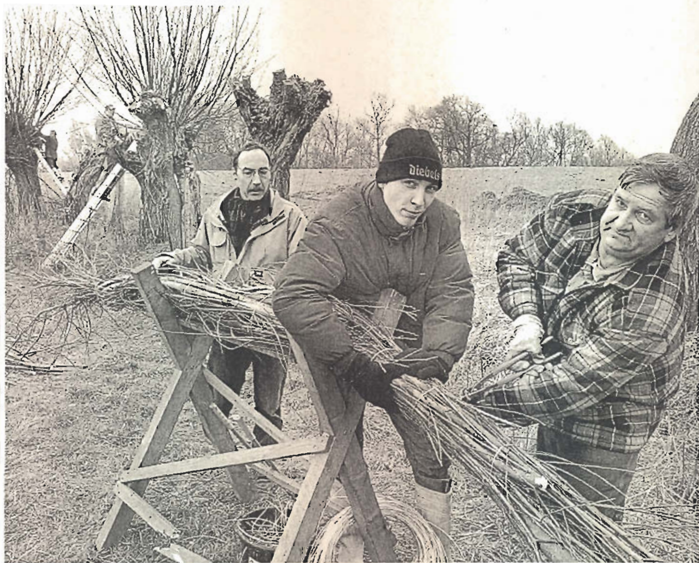
Faschinenbau in Löhne: Vorarbeiter Alexander Schreider (v.r.), Sven Nicklaus und der Fachanleiter, Biologe Gerhard Papsch haben die Kopfweiden geschritten, binden die Äste zu einer Maschine. Sie wird als natürliche Uferbefestigung verbaut.
