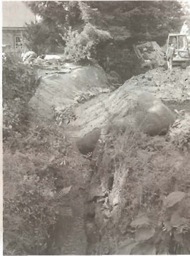
Varher und nachher: Mit schwerem Gerät rückten die Einsatzkräfte dem Mittelbach in Löhne 2002 zu Leibe, verbreiterten das Flussbett und bepflanzten es anschließend wieder. Fotos: BZ
