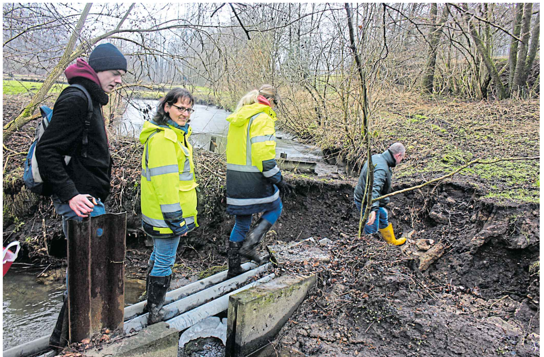
Risikante Kletterpartie: Vertreter des Kreises, der Stadt Herford und der Biologischen Station Ravensberg überqueren den Heier Mühlenbach in Eickum, um bei der Gewässerschau die eingestürzte Zulaufstelle für die Teichanlagen zu begutachten. Archivfoto: Isabelle Helmke
