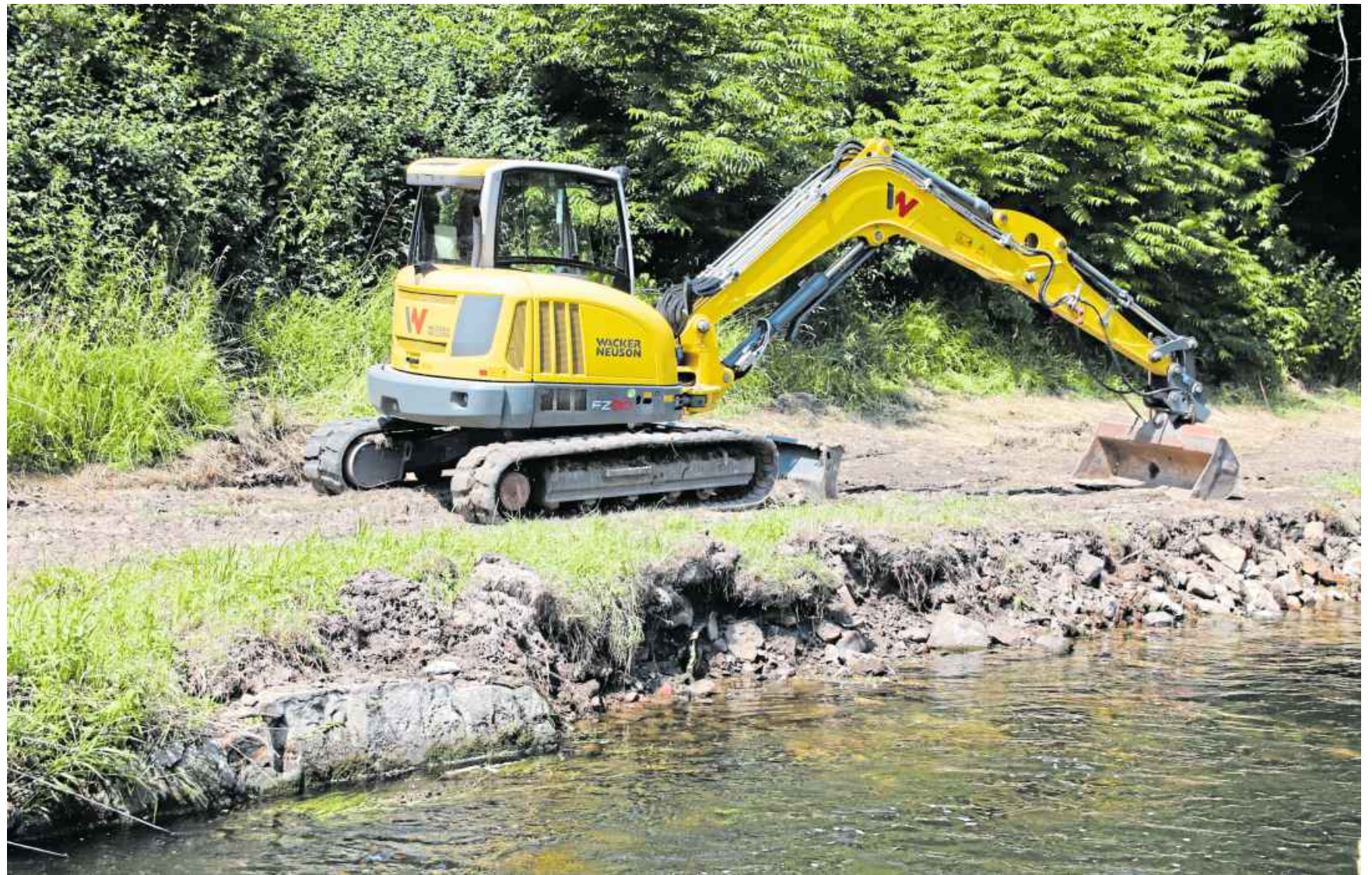
Die Werre wird am Rischmüllerufer renaturiert. Dafür trägt der Bagger die Betonelemente ab, um dem Fluss mehr Platz zu geben.
