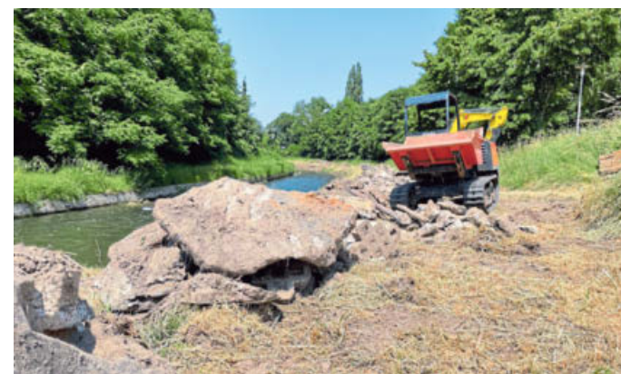
Durch die Entfernung der Betonbefestigung soll die natürliche Entwicklung des Flusses gewährleistet werden. FOTO: BENEDIKT RIEMER
