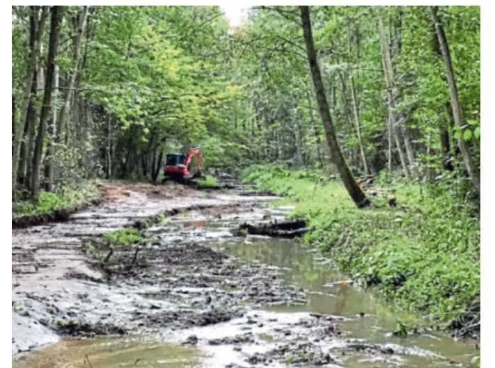
Das Wasser nagt kontinuierlich an den Rändern der Abbruchkante. Der Brandbach wird sich so nach und nach in seinem neuen Bett ausbreiten.
