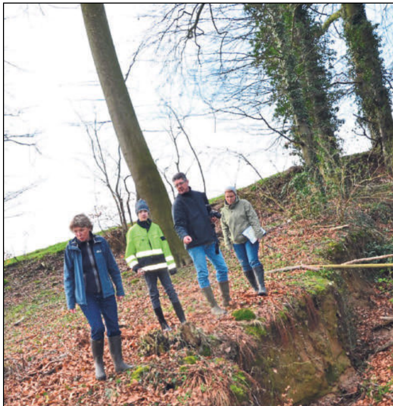
Doris Bartelheimer (von links), Xander und Heinrich Linnert sowie Nora Hillemeier begutachten die Folgen der Erosion oberhalb der Quelle des Südholzbachs. Foto: Daniela Dembert
