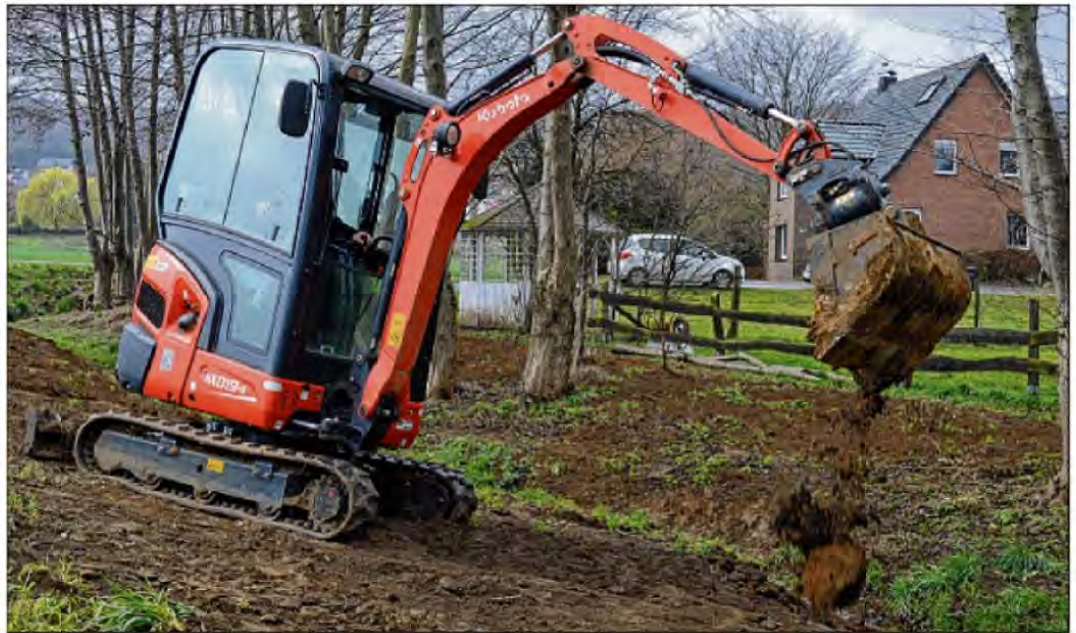
Mithilfe eines Baggers wird der Uferbereich des Bachs neu gestaltet.
