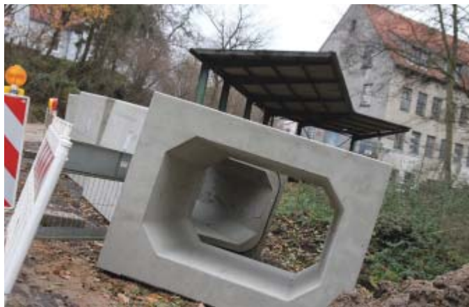
Viel Platz: Durch diese Betonsteine wird der Bach unter der Straße fließen – sie lassen auch Tieren Platz zum Durchwandern. FOTO: A. NEUL
