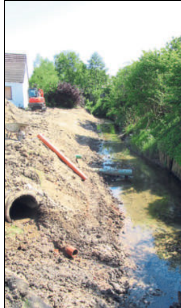
Arbeiten am Schnathorster Bach, Zur Buxtermühle. Fotos: Gemeinde Hüllhorst
