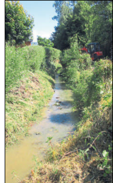
An der Industriestraße am Tengerner Bach laufen derzeit Maßnahmen.
