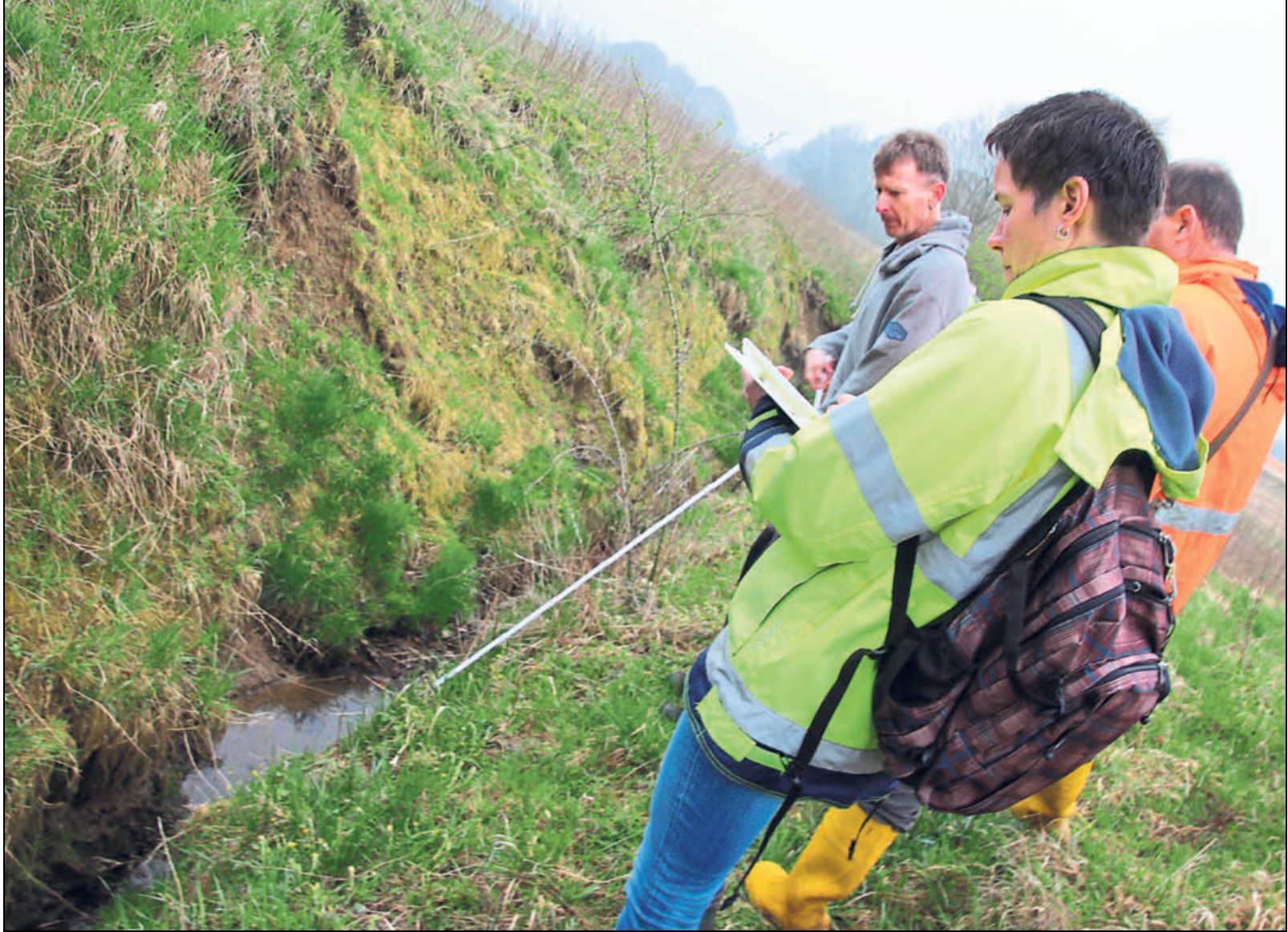
Carsten Vogt, Claudia Hopfinger und Armin Kuschel begutachten kritisch die tief eingegrabene Sohle des Eselsbachs. Für einen naturnä-
