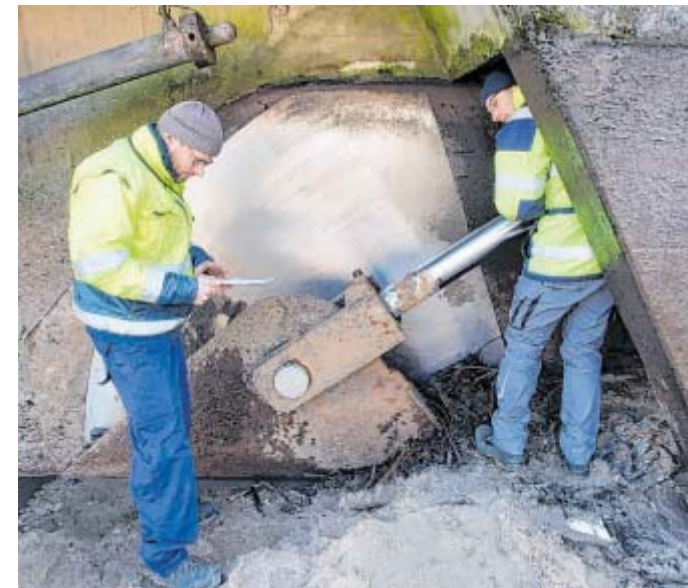
In die Jahre gekommen: Christoph Wedler und Jens Kölbel prüfen den hydraulischen Antrieb, der mit Druck von 200 bar arbeitet.
