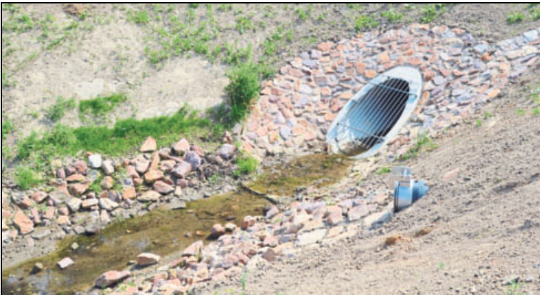
Nachdem er die Piviststraße unterquert hat, tritt der Bach hier an die Oberfläche. Zu sehen ist auch die Verrohrung, die vom neu angelegten Retentionsbodenfilterbecken in den Bach führt.
