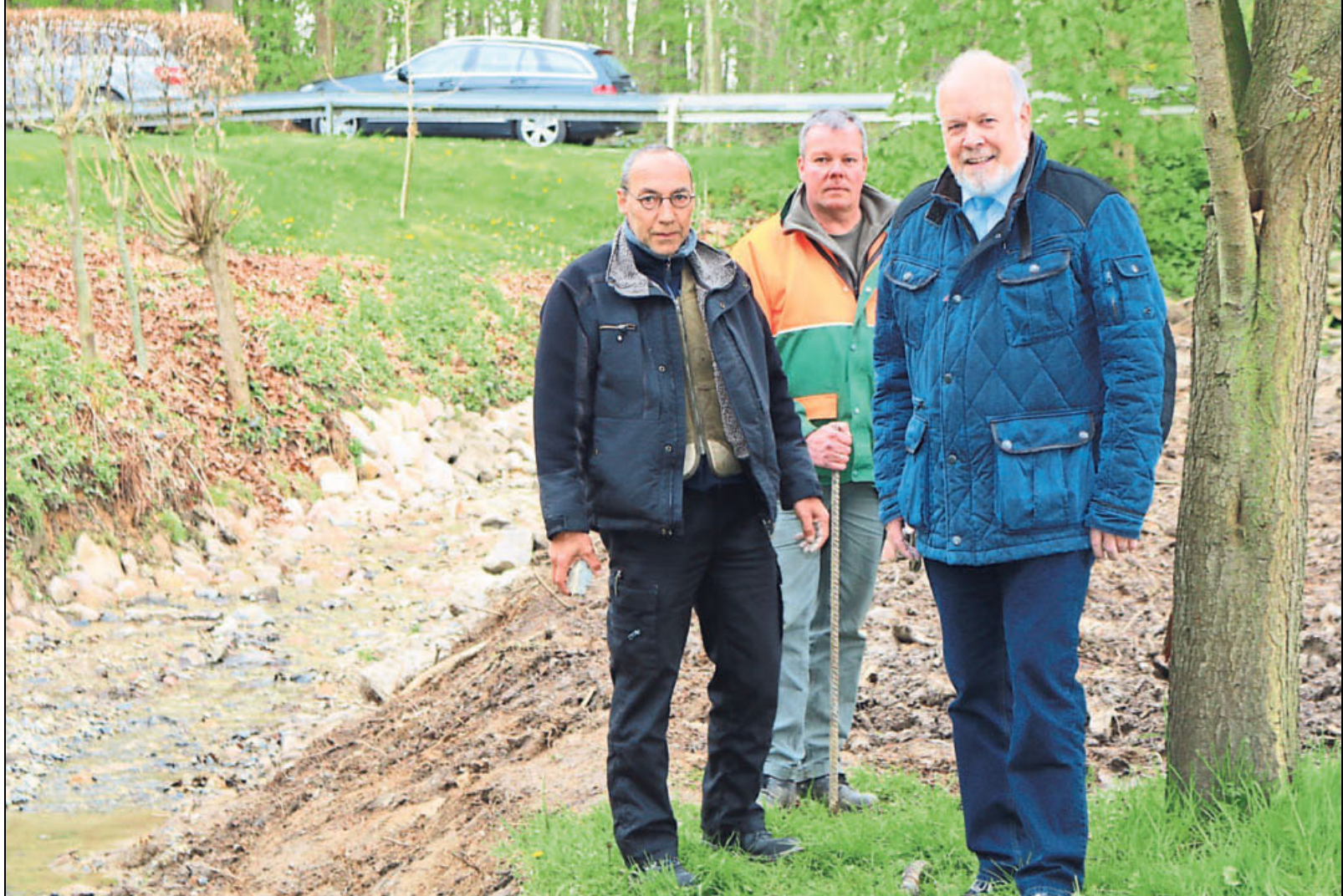
Gerhard Papsch von der Evangelischen Stiftung »Maßarbeit«, Vorarbeiter Manfred Lange und Kirchlengerns Oberhaupt Rüdiger Meier (von links) besichtigen den Kämperbach. Er wurde unter anderem durch die Ausarbeitung einer Sohlgleite renaturiert. Foto: Raphael Steffen
