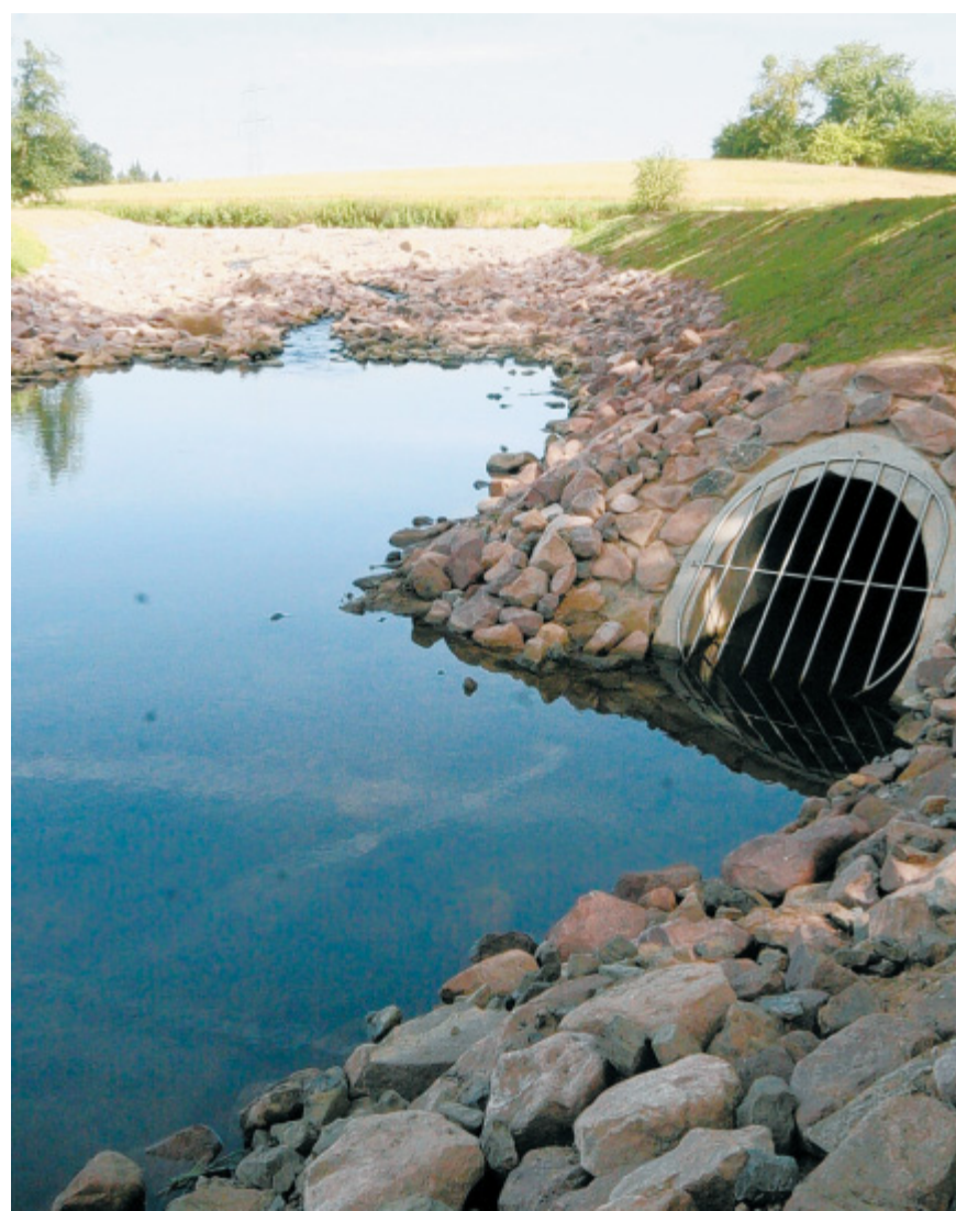
Einst und heute: Der Mühlenbach an der Ulenburg musste sich früher durch das alte Wehr kämpfen. Fische hatten kaum eine Chance, diese Stelle zu passieren. Die neue Sohlgleite macht es ihnen nun viel leichter.
