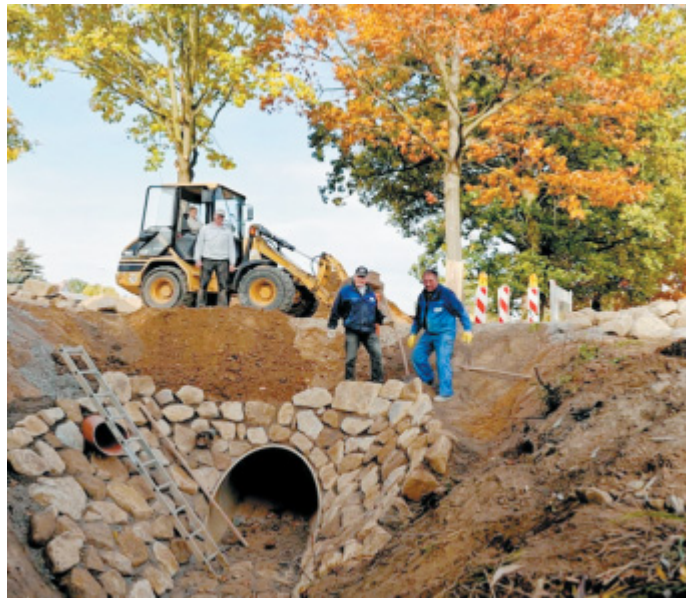
Natursteine zur Verschönerung: Vorarbeiter Mario Schwabach und seine Kollegen Andreas Ochsenfurth und Günter Hirschmann (v.l.) machen aus dem Durchlass einen Hingucker.
