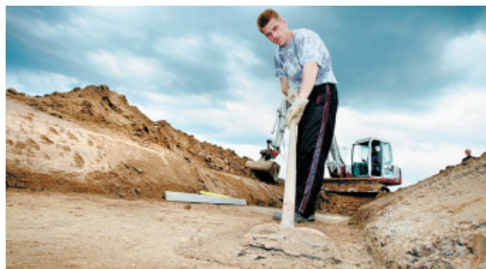
Gemachtes Bett: Ein Maßarbeit-Mitarbeiter macht nach dem Bagger die Feinarbeit. Mit der Wasserwaage im Hintergrund prüft er, ob sie das Gefälle von 0,5 Prozent einhalten.
