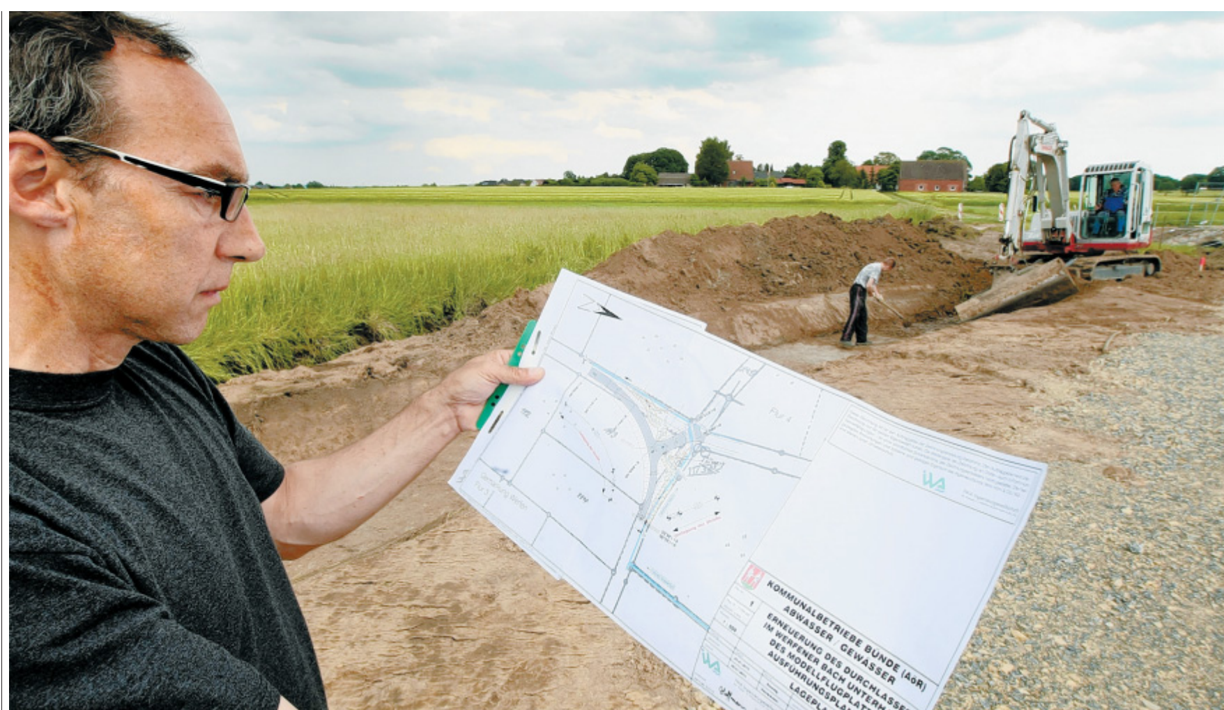
So wirds aussehen: Diplom-Biologe Gerhard Papsch hält den Plan des neuen und alten Bachverlaufs. Bisher verläuft der Bach schnurgerade und biegt im rechten Winkel ab, in Zukunft wird er einen Bogen machen. Grau ist der Weg eingezeichnet, der neben dem Bach verlaufen wird. Im Hintergrund gräbt der Bagger das neue, breitere Bett. FOTOS: PATRICK MENZEL
