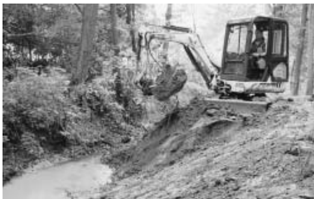
Baggerarbeiten: Mit schwerem Gerät wird die Böschung abgeflacht, der Bachlauf soll geringfügig erweitert werden.
