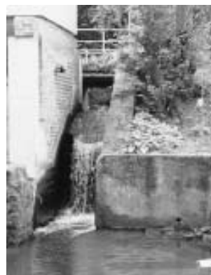
Wassersturz: Der Bach wird an dieser Stellen umgeleitet.
