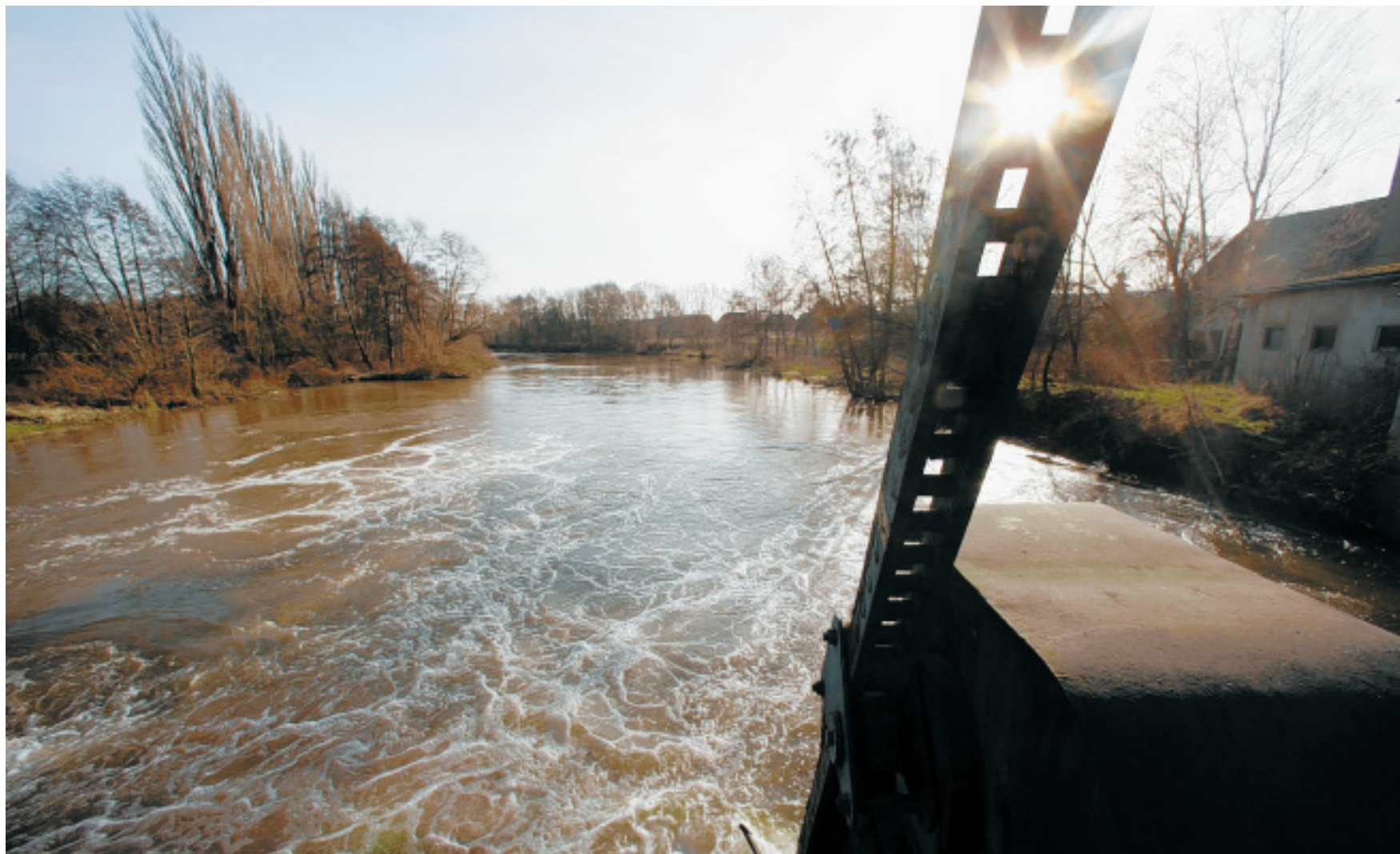
Soll beseitigt werden: Wehre, wie das an der Brausemühle in Südlengern, unterbrechen den natürlichen Flussverlauf.
