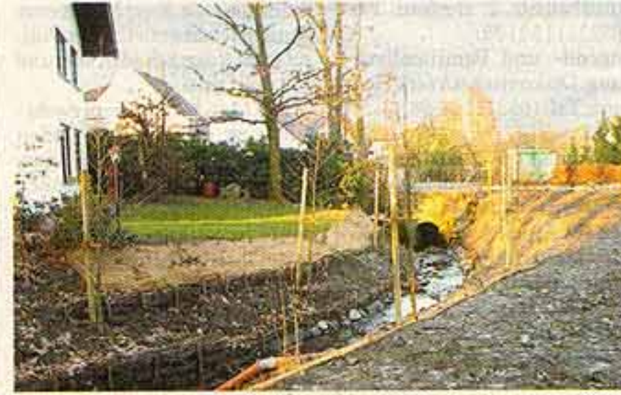
Nachher: Der Bach ist freigelegt worden und hat ein neues Bett bekommen. Er fließt jetzt offen durch den Garten des Hauses.
