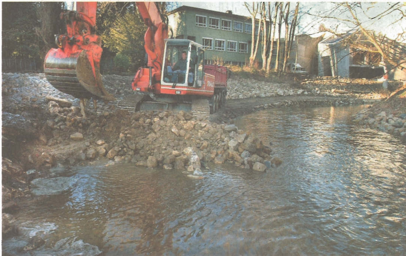
Neuer Schwung für die Aa: Direkt an der MARTa-Baustelle kann sich der innerstädtische Fluss jetzt ausdehnen. Das Uferprofil ist verbreitert worden und kleine Inseln und Totholz sorgen für Abwechslung, sollen Wanderfischen wie dem Lachs eine Heimstatt bieten. FOTO: KIEL-STEINKAMP
