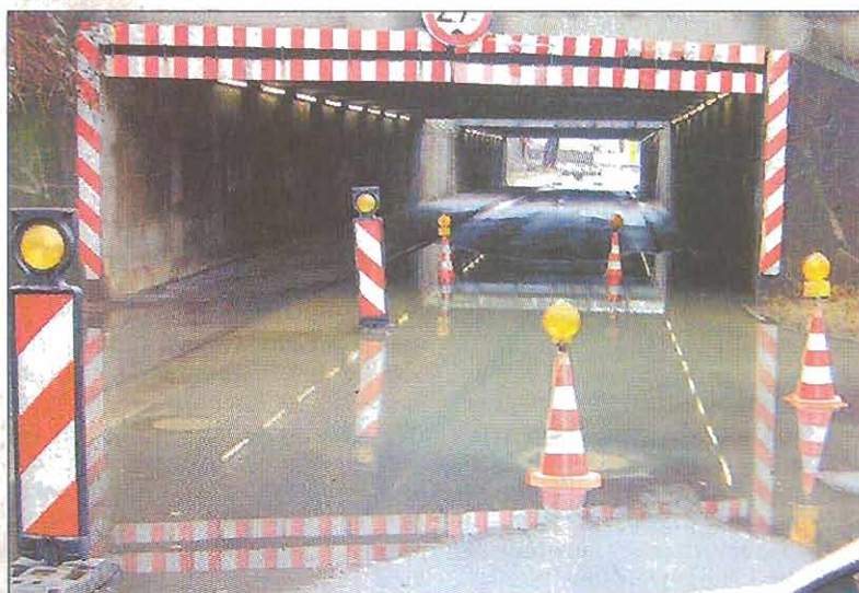
Beim Jahrhunderthochwasser komplett geflutet: der Bereich zwischen Elbe und den Bahnschienen, zu dem auch die verkehrstechnisch wichtige Unterführung an der Gerhard-Hauptmann-StraÙe gehört.
