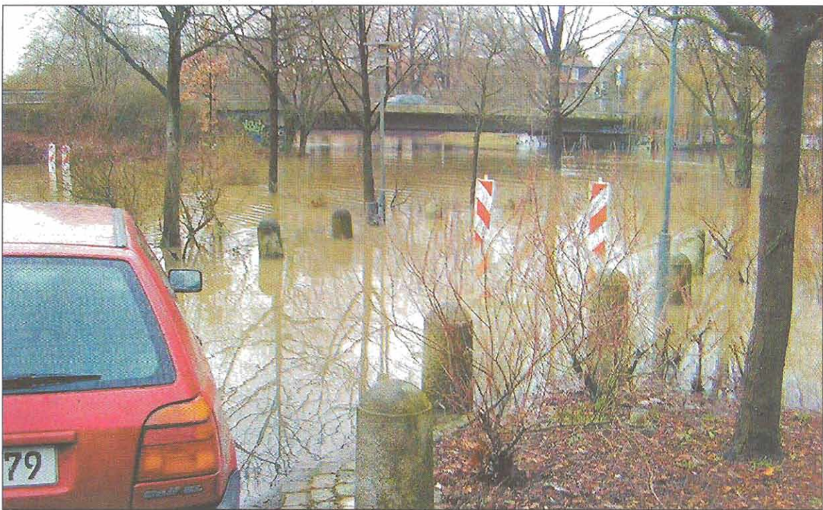
Vertrauter Anblick: der Parkplatz am Rathaus, bei Hochwasser regelmäßig überschwemmt. »Das Rathaus hätte an dieser Stelle niemals gebaut werden dürfen«, urteilt Experte Carsten Vogt. Fotos: BZ-Archiv
