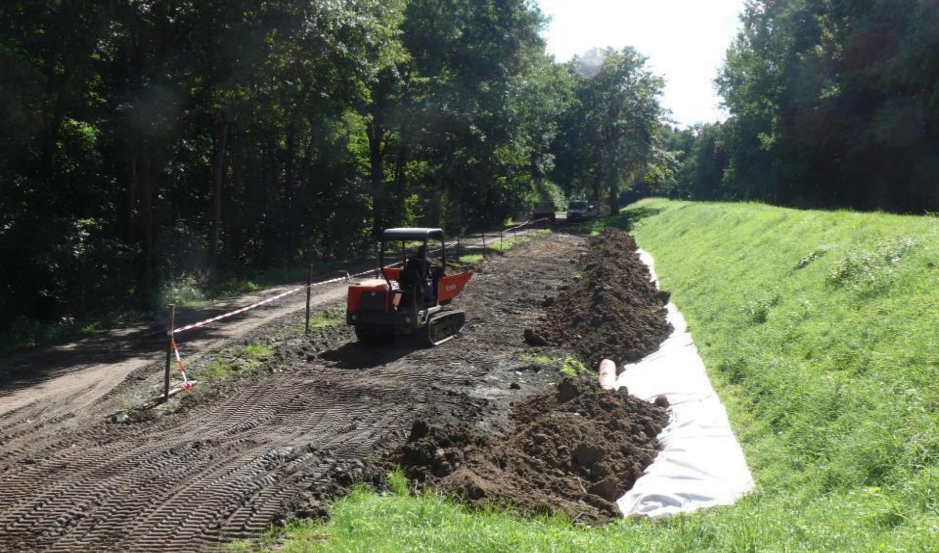
Für die Bodenmiete wurde der Graben kurzfristig verrohrt und die Böschung zum Deich mit Flies ausgelegt
