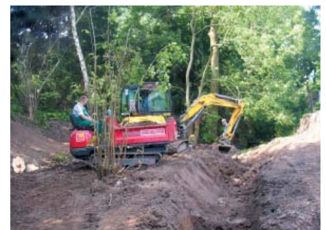
Abb. 12: Einsatz von Minibagger und Raupenkipper Foto: Koordinationsbüro
