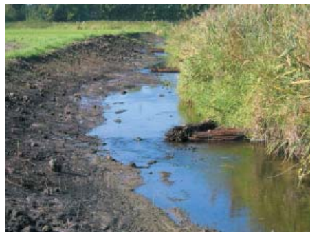
Abb. 3: Strömunglenker Foto: Koordinationsbüro
