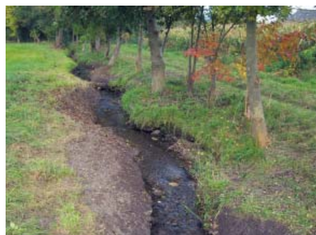
Abb. 4: Wechelseitig aufgeweitetes Gewässerprofil Foto: Koordinationsbüro
