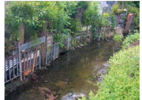
Abb. 11: Naturferne Ufersicherung / Eingengung des Bachprofils Foto: Koordinationsbüro
