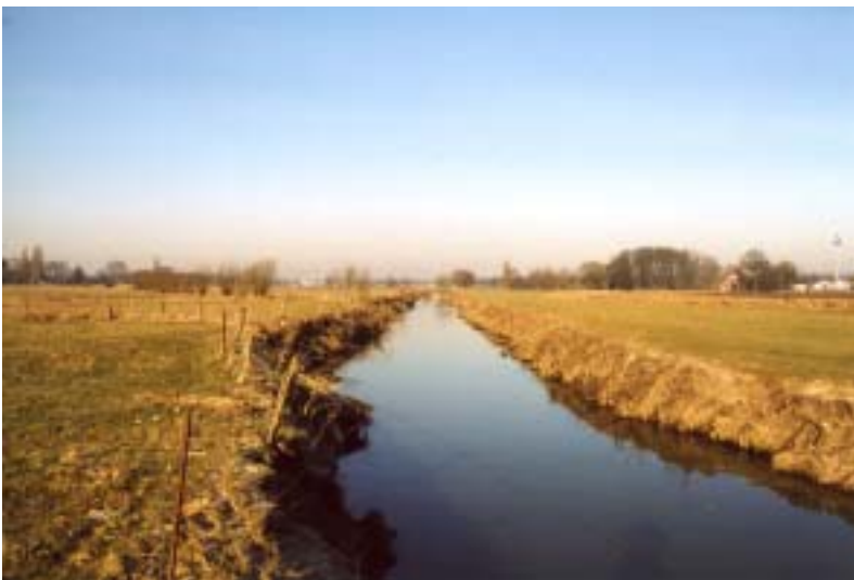
Im Zuge der Regulierung wurde die Else bei Bünde (1927 – 1929 und 1934 - 1937) begradigt und mit einem Trapezprofil versehen, so dass seitdem der Fluss nahezu leblos wirkt und das Wasser rasch abführt
