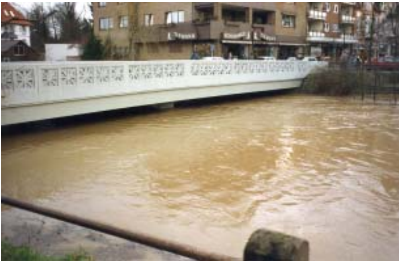
Bsp. Bünde: Brückenbauwerke an Fließgewässern gelten i.d.R. als hydraulisches Nadelöhr, da mögliche Verstopfungen zu Rückstauungen und somit zu Überschwemmungen des Umlandes führen können (Bildquelle: Stadt Bünde, Hochwasser vom 28. Januar 1994)
