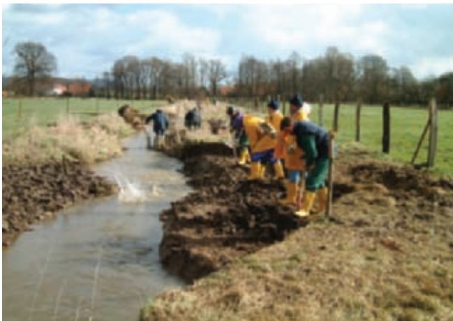
Bild 1: Arbeiten zur naturnäheren Entwicklung der heimischen Fließgewässer können häufig nur in Handarbeit erfolgen.
