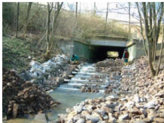
Bild 6: Pfeiffenbrinkscher Sohlenabsturz (Foto: Koordinationsbüro)
