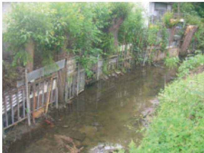
Bild 11: Naturferne Ufersicherung/Einengung des Bachprofils (Foto: Koordinationsbüro)
