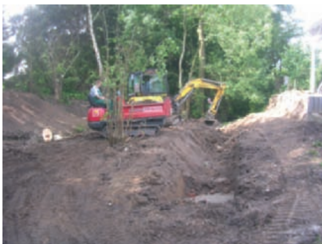
Bild 12: Einsatz von Minibagger und Raupenkipper (Foto: Koordinationsbüro)
