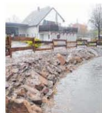
Die Lösung: Eine Uferbefestigung aus Steinen.
