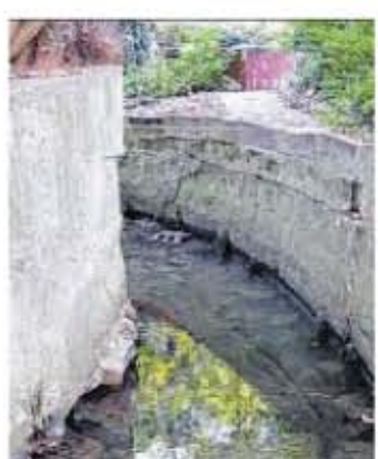
Eingepfercht: Der Osterbach zwischen dicken Mauern.
