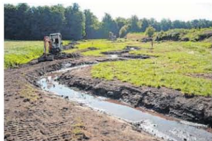
Kurvig statt gerade: Der Wulferdingsener Bach hat seit 2009 deutlich mehr Platz.
