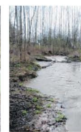
Bachverlegung: An der Bachstraße wurde der Borstenbach von der Straße abgerückt.
