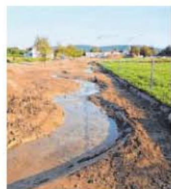
Nachher: Der Verlauf der Bachs wurde verlegt.
