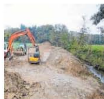
Aushub: Platz für die Ersatzaue wird geschaffen.
