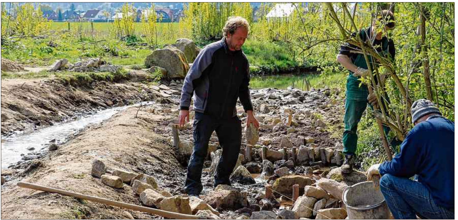
Früher wurde Wasser aus dem Mühlenbach durch einen verrohrten Zulauf in den Löschteich geleitet. Mitarbeiter des Gewässerentwicklungsprojekts „Weser-Werre-Else“ haben unter Anleitung von Sven Kammeier (links) das Rohr entfernt und ein Stück des Mühlenbachs mit Steinen renaturiert (rechts auf dem Bild).
