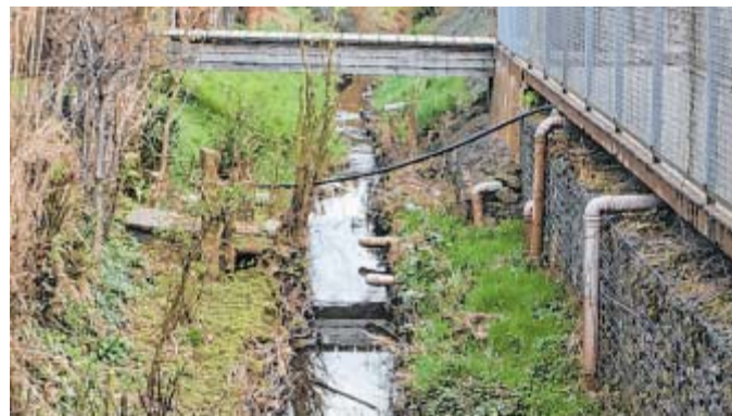
Der Ostscheider Bach: Hier fließt er durch dicht besiedeltes Gebiet. Rechts sind die Entwässerungsrohre von angrenzenden Grundstücken zu sehen.
