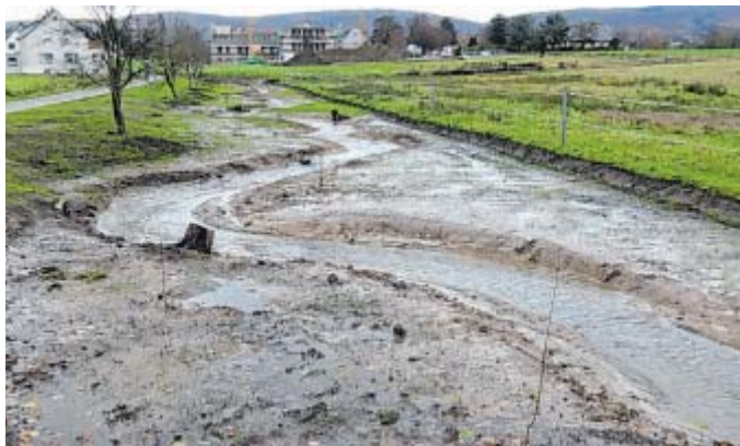
Mehr Platz: Der Volmerdingsener Bach schlängelt sich am Fesselgrund durch einen zehn Meter breiten „Korridor“. FOTO: JÖRG STUKE
