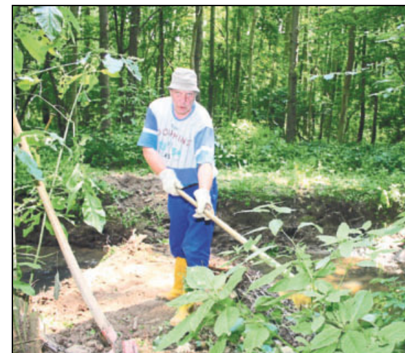
Freko Heller von Maßarbeit repariert einen Strömunglenker. Fotos (2): Ueckermann
