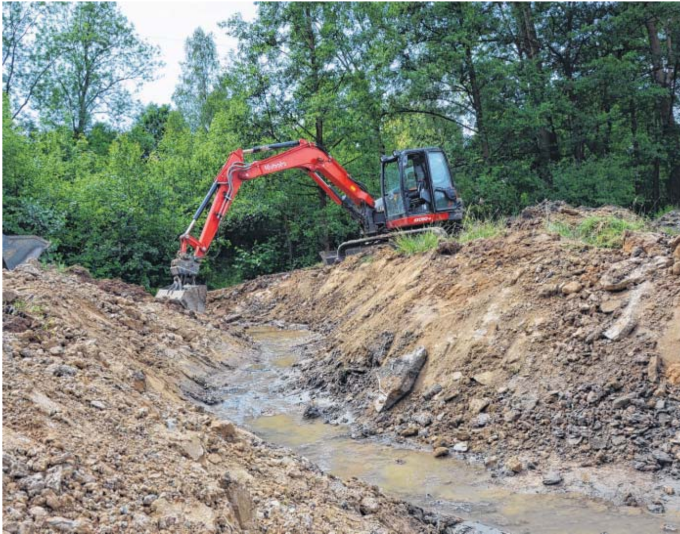
Stark geschwungen: Der Bagger gräbt einen neuen Bachlauf für den Osterbach. Mitte August sollen die Arbeiten beendet sein.
