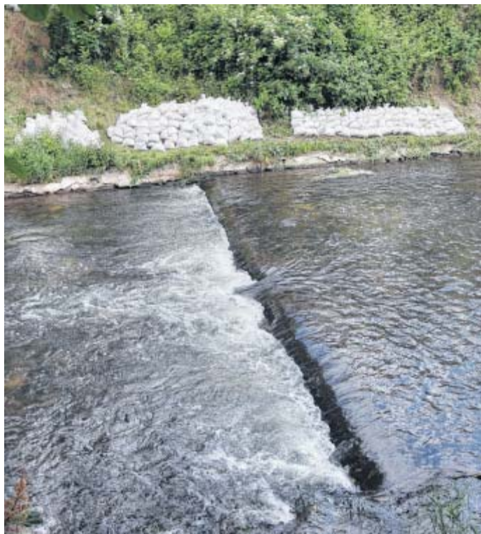
Sandsäcke deponiert: Die Arbeiter werden sich mit den Säcken halbwegs trockene Arbeitsplätze im Wasser schaffen. FOTO: KIEL-STEINKAMP
