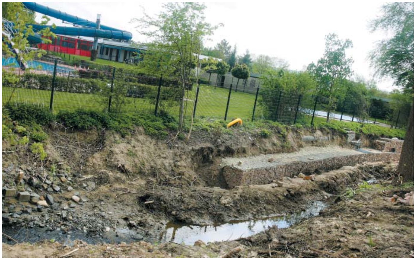
Bach bekommt mehr Platz: Am auf der Rückseite des Freizeitbades „Aqua Fun“ verlaufenden Markbach laufen momentan Hochwasserschutzmaßnahmen. Das reicht allein reicht aber nicht für Starkregenfälle wie im vorigen Sommer aus. FOTO:DIETER SCHNASE
