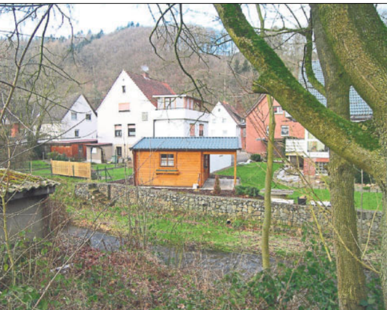
An Lüdekingsgarten: Die zurückverlegten Steinmauern der Ufer hinter Drahtgeflecht sind zum Teil bereits überwachsen. Einst gab es hier enge marode Betonmauern und kaum Überschwemmungsflächen.
