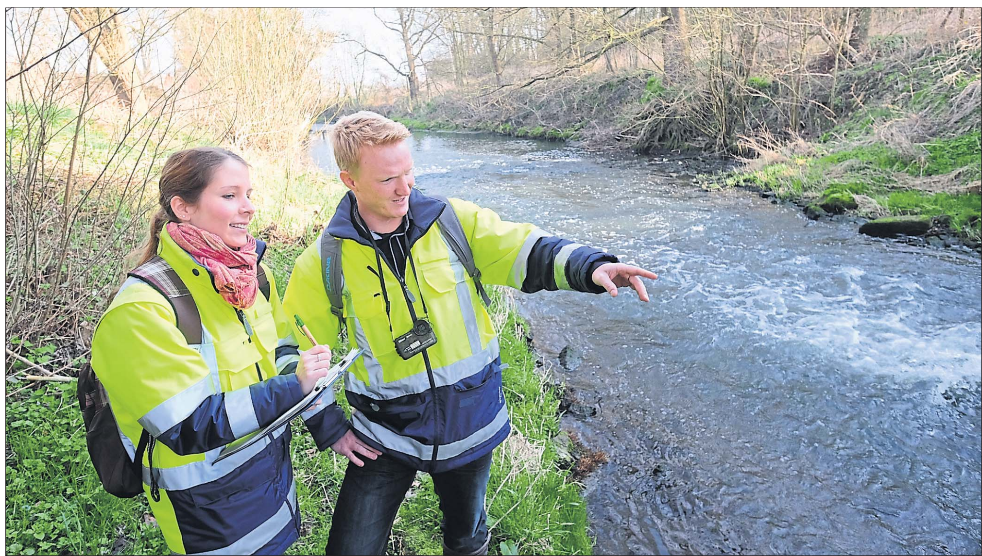
Viele Kilometer sind die Mitarbeiter der Unteren Wasserbehörde und der Landschaftsbehörde des Kreises Herford an den Flüssen und Bächen abgelaufen. Wasserbauingenieurin Maren Bartels und Umweltschutztechniker Daniel Schönlein begutachten hier die Aa in Elverdissen, machen Fotos und schreiben Protokolle. Foto: Moritz Winde
