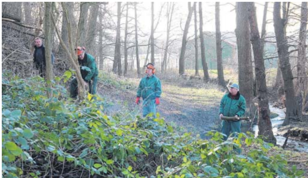
Im Einsatz: Vorarbeiter Juri Kremser (l.) und sein Team bereiten den Uferbereich des Borstenbachs für die im März beginnende Renaturierungsmaßnahme vor.
