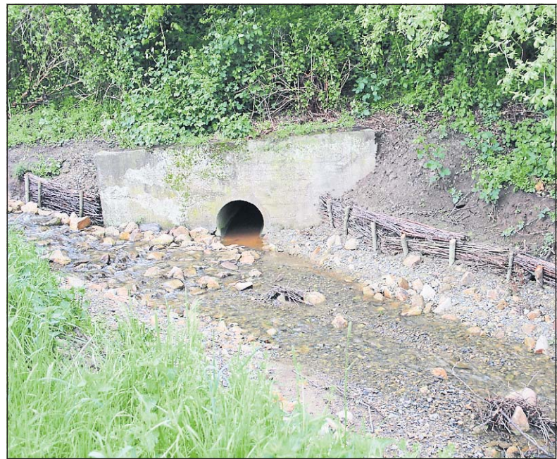
Nachher: Jetzt kann der Bach nicht nur durch die Röhre, sondern auch von links über einen größeren Durchlass fließen. Die Sohle ist angehoben.
