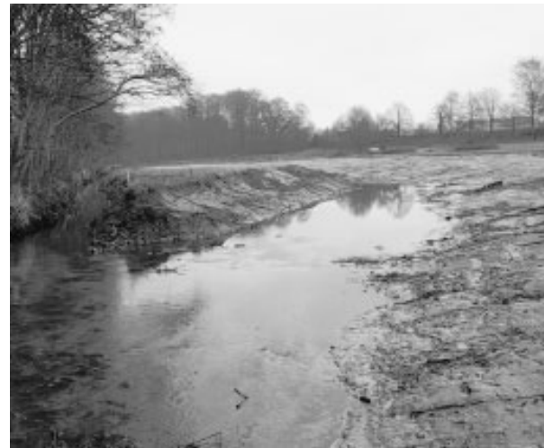
Gabelung: Im neuen Bett (r.) darf sich der Bolldammach entwickeln. Der alte Verlauf (l.) bleibt erhalten.
