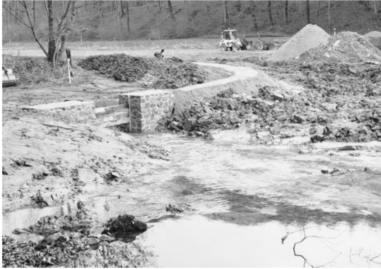
Rückhaltebecken: Aus Natursteinen wird im Bereich der Holzbrücke eine Rückhaltemöglichkeit mit einem Volumen von 10.000 Kubikmetern errichtet. Auch das gehört zu einer lebendigen Bachaue.
