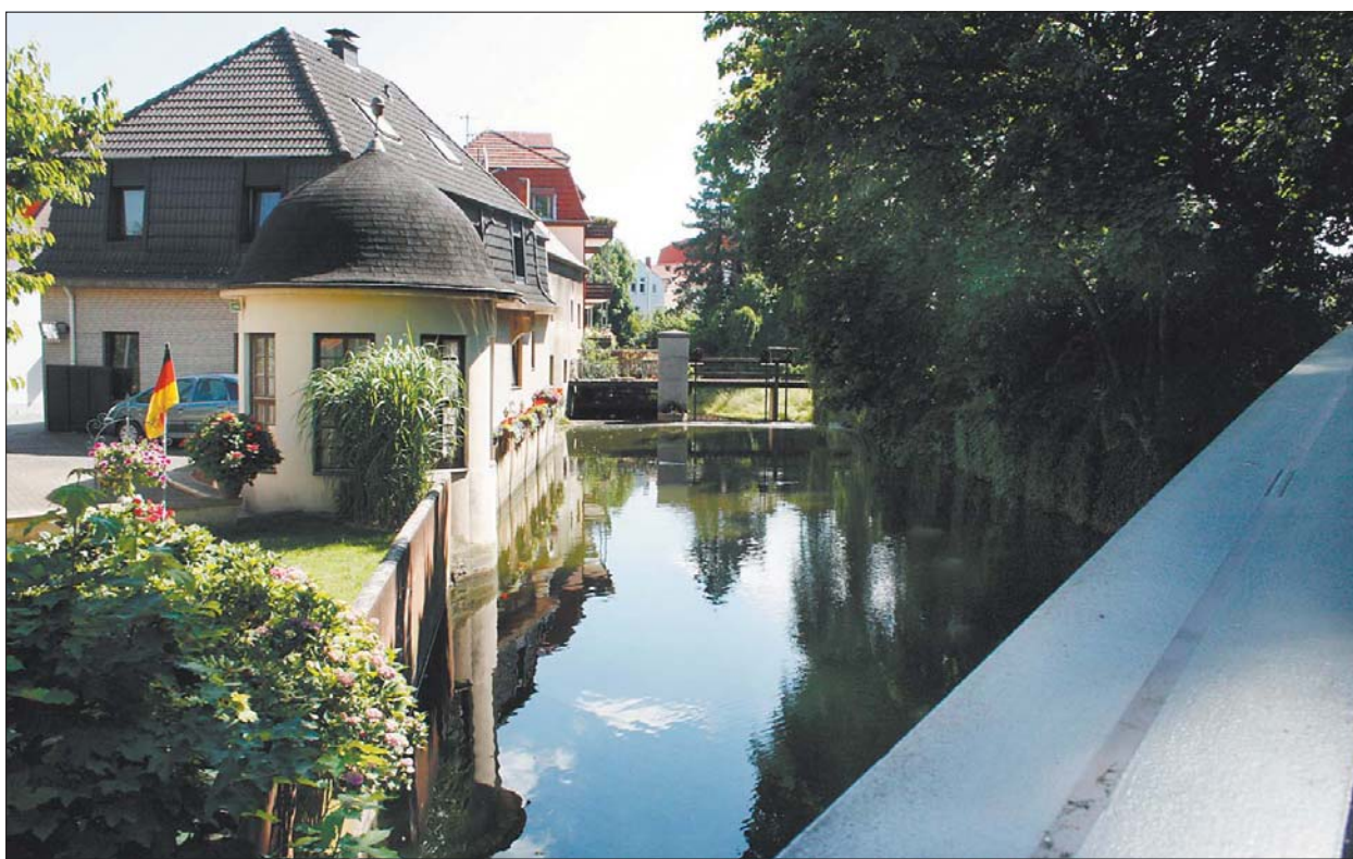
Auch der viel diskutierte Umbau des Radewiger Wehres (Foto) und die Neugestaltung der Aa bis zur Umgehungsstraße (B 239) ist eines der Projekte zur Umsetzung der EU-Wasserrahmenrichtlinie. Deren Ausgestaltung vor Ort diskutierten Beteiligte gestern im Kreishaus. Fotos: Bexte
