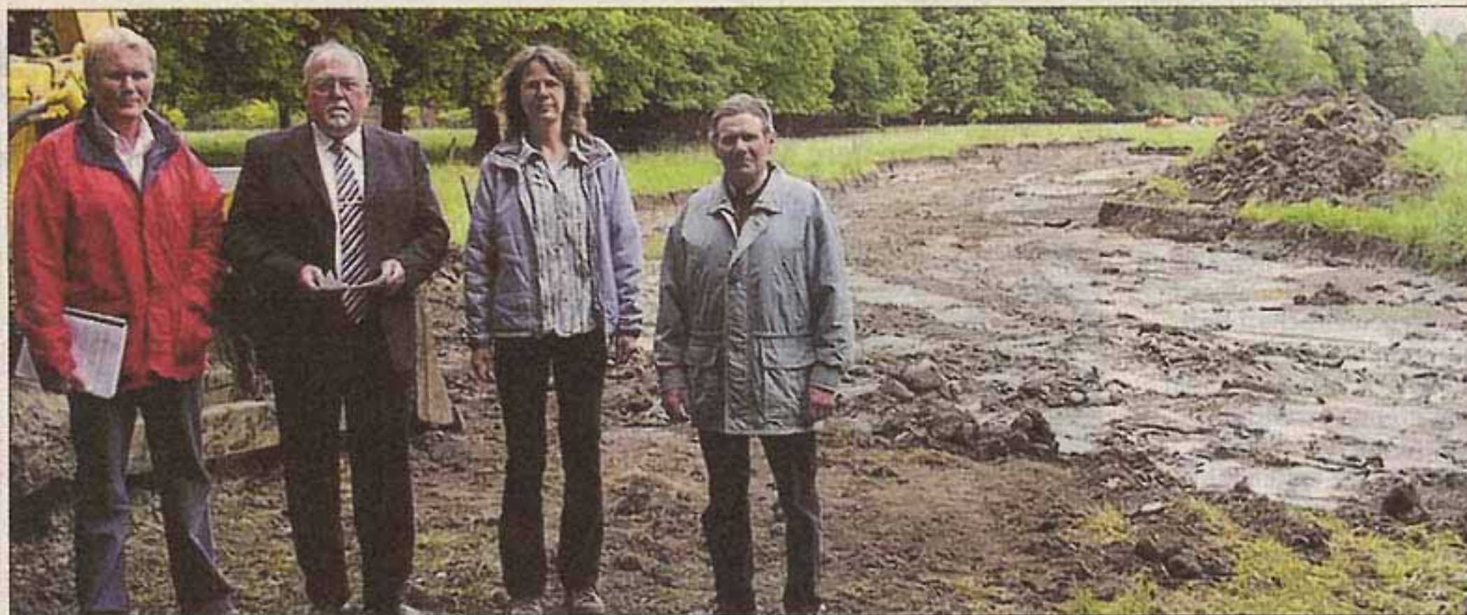
Bauamtsleiter Helmut Spilker, Bürgermeister Reinhard Jasper, Projektleiterin Carola Fürste und Walter Gerdsmeier, stellvertretender Verbandsvorsteher des Wasserverbandes Große Aue (von links) vor dem zukünftigen Bachlauf. MT-Fotos: Gisela Burmester
